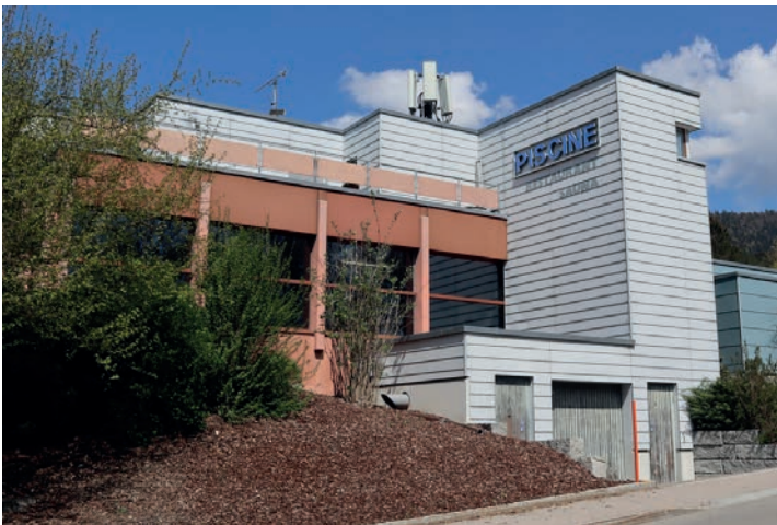
On nagera dans l'installation de l'Orval jusqu'au 30 juin, ensuite de quoi commenceront les grands travaux.
